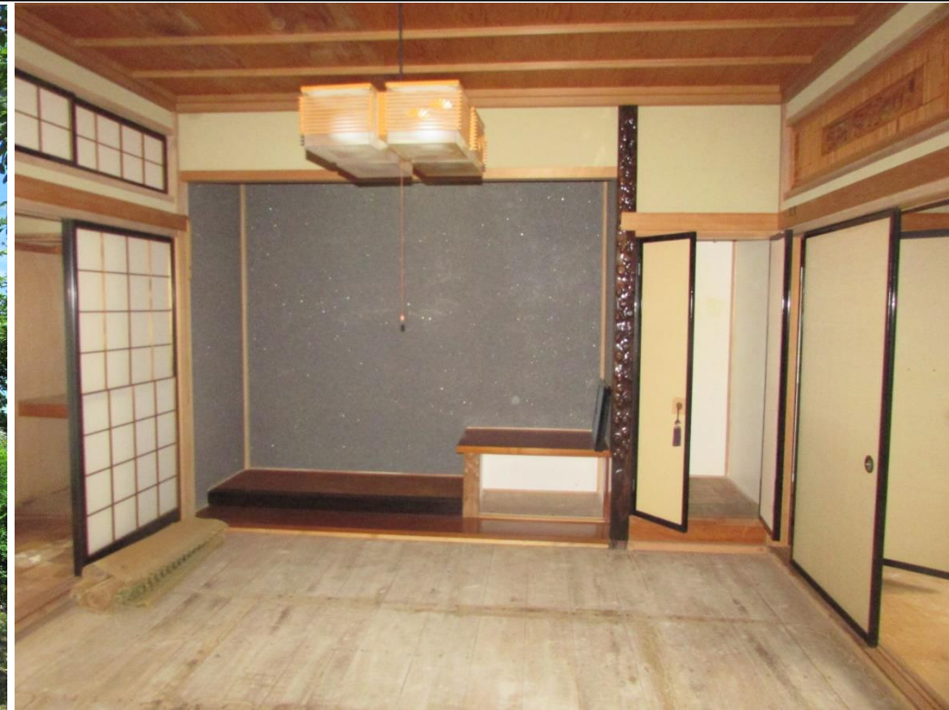
・空き家の内観(真壁造りの1階和室)
