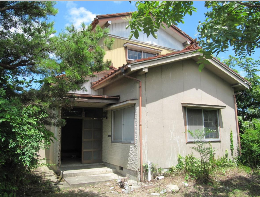
・空き家の外観(東側)
