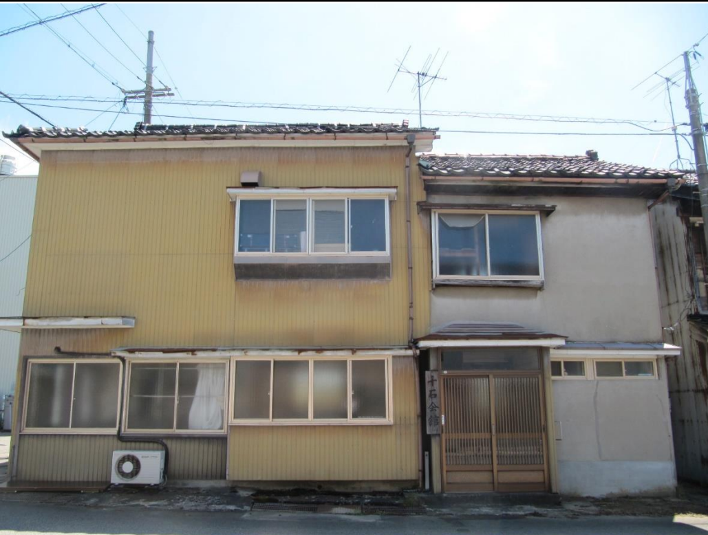
・空き家の外観（北側）
