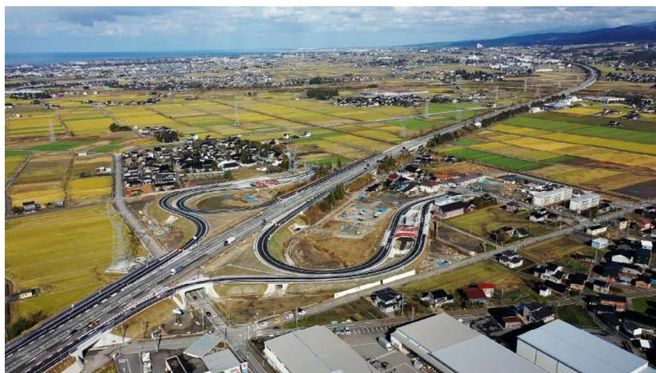
上市スマートインターチェンジ
