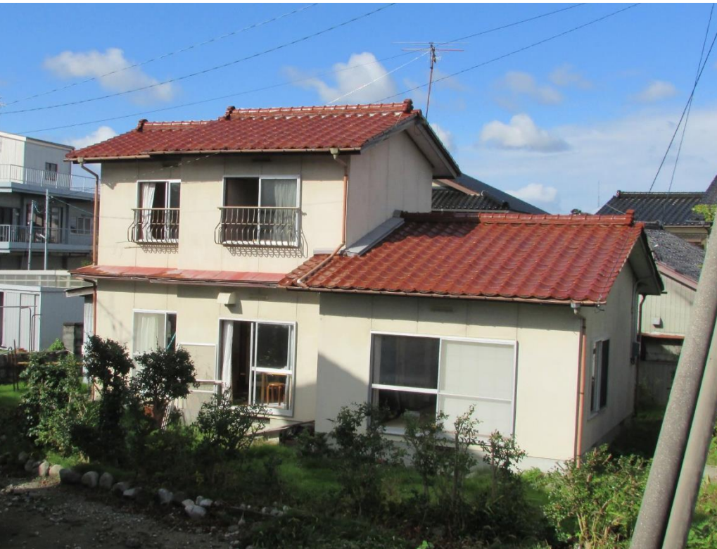
・空き家の外観（東側）
