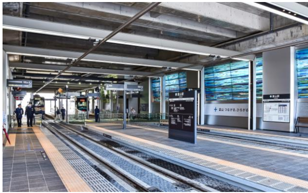
路面電車の南北接続
