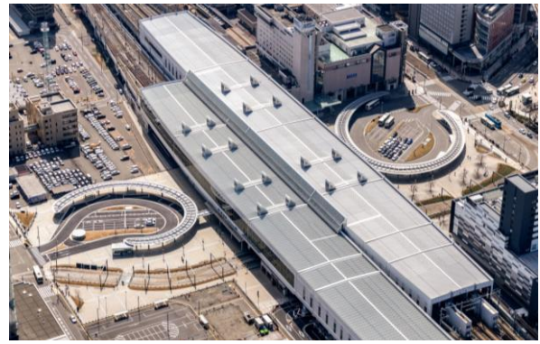
駅北口駅前広場の整備
