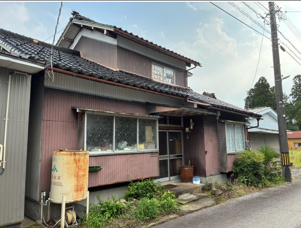
・空き家の外観（南東側）
