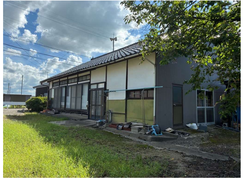
外観(北面、西面)
