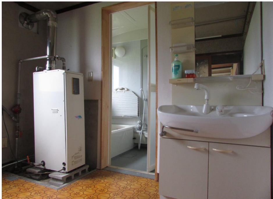
内観(洗面脱衣室)
