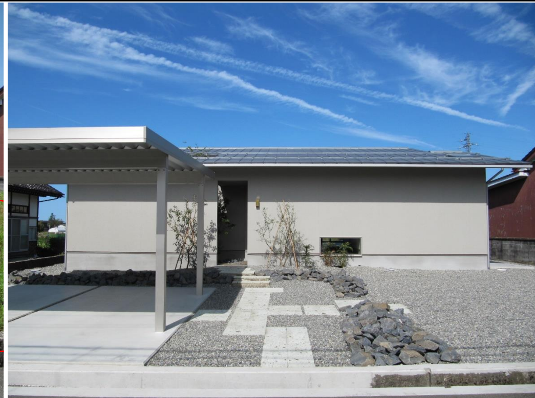
・外観(南側):住宅が完成
