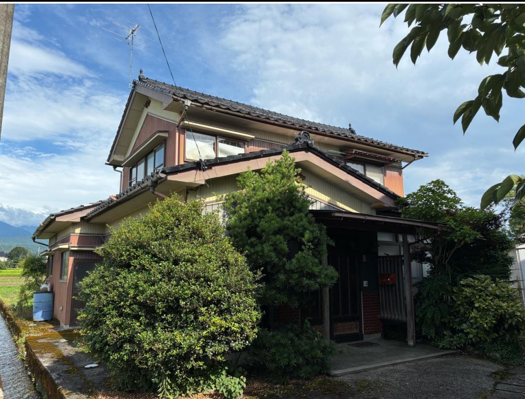
・空き家の外観(西側)
