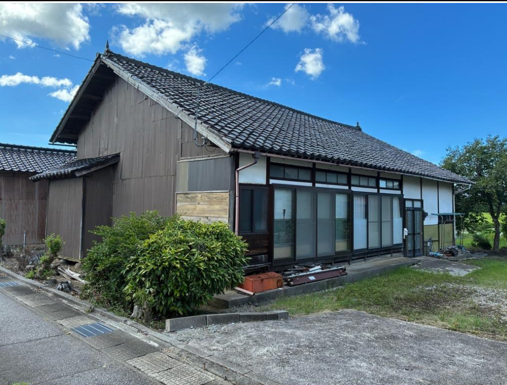
・空き家の外観(南西側)
