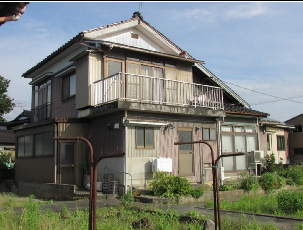
・空き家の外観(西側)
