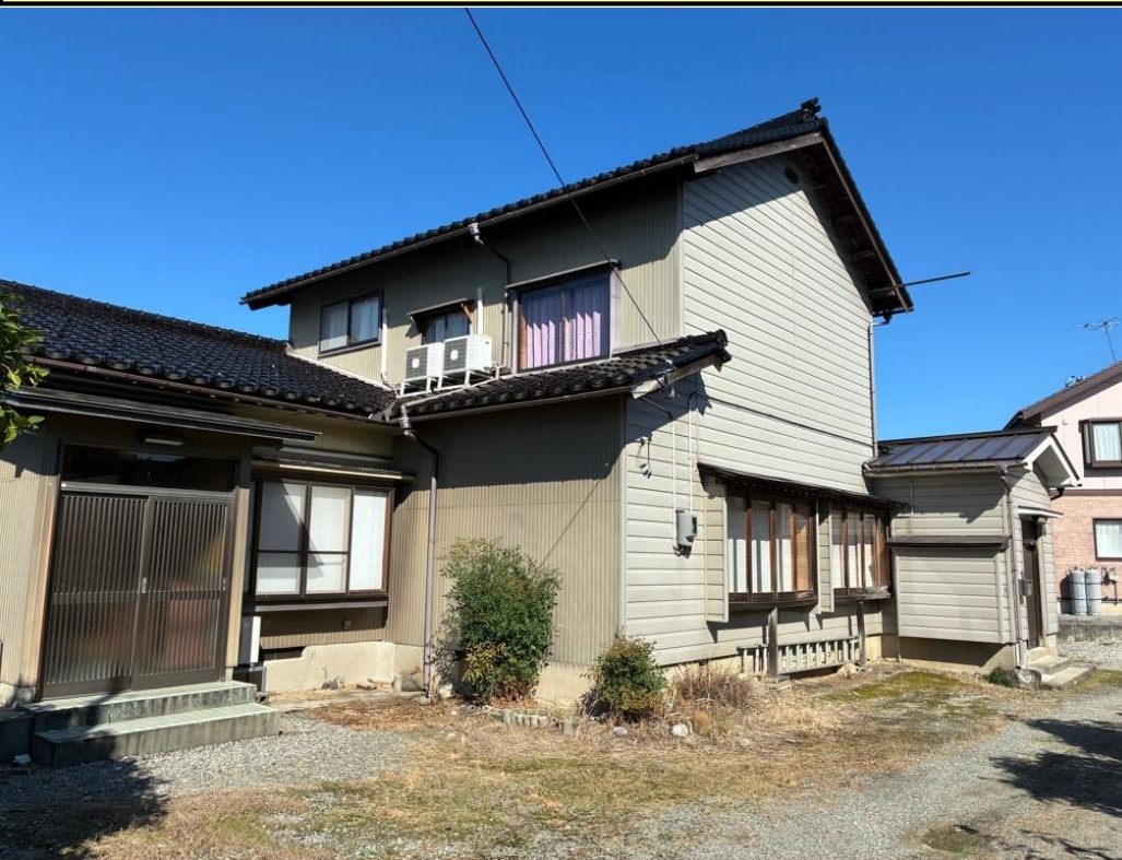
・空き家の外観(東側)
