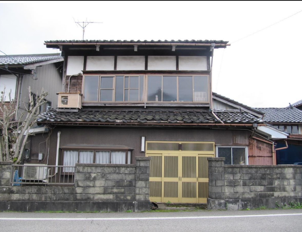
・空き家の外観(北側)
