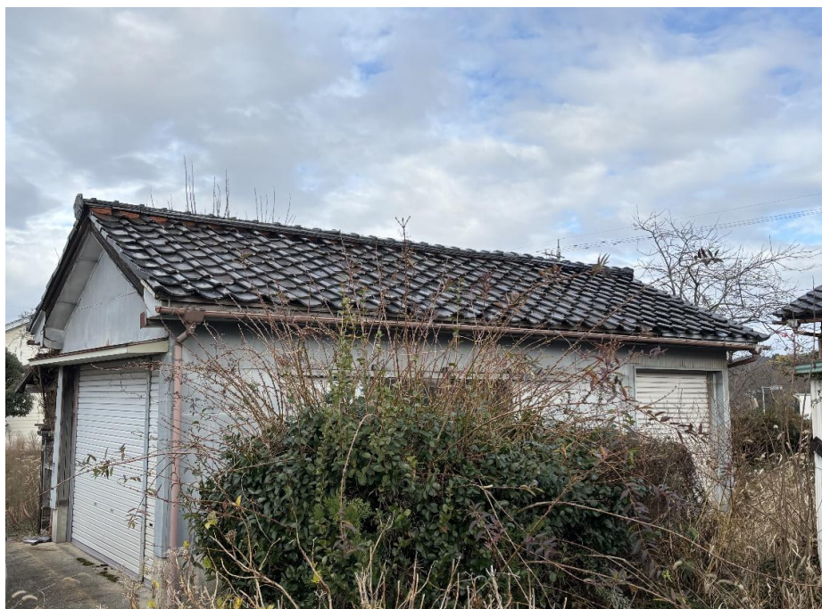
外観(倉庫③)
