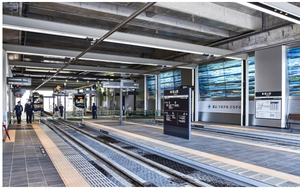
路面電車の南北接続
