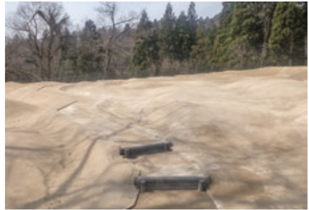
土系固化舗装施工後
