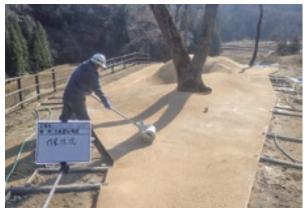
土系固化舗装転圧作業
