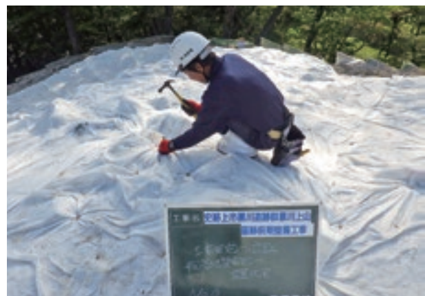
シート敷設作業
