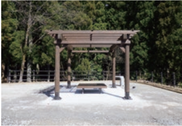
パーゴラ設置状況
