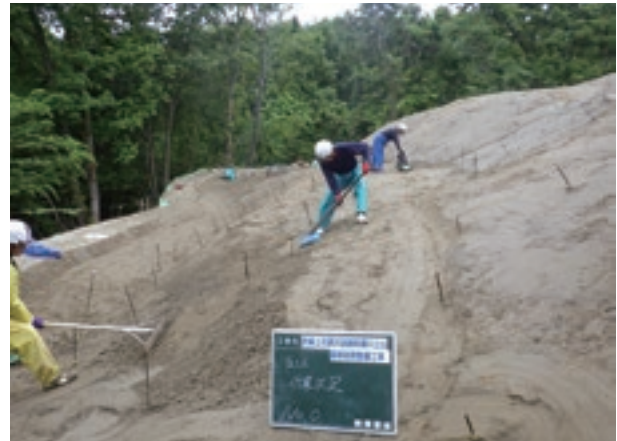
盛土敷均し作業
