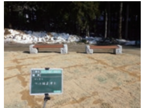
ベンチ設置状況
