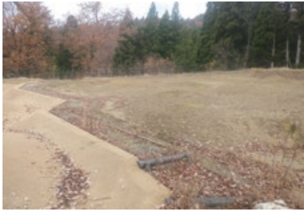
土系固化舗装施工前
