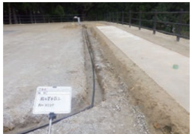
給水管布設状況
