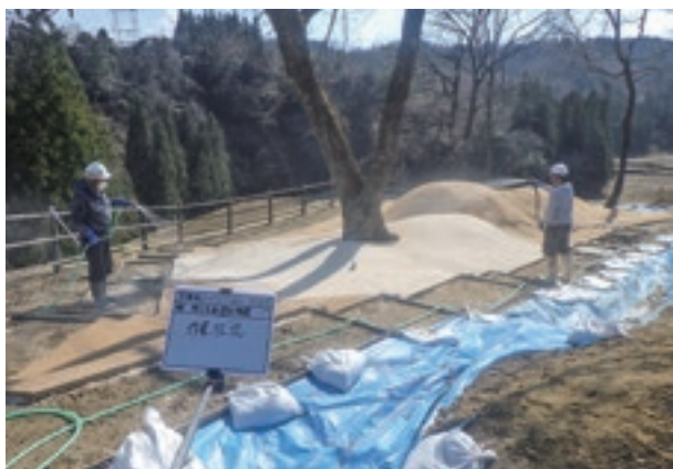
土系固化舗装散水作業
