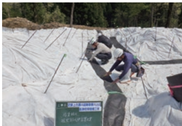
暗渠排水材敷設作業
