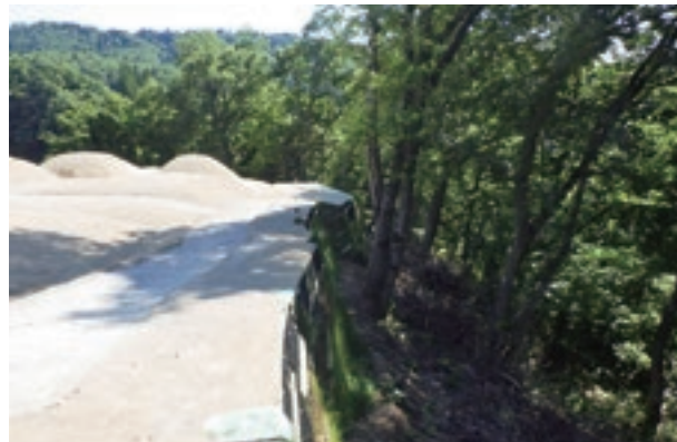
補強土壁工施工後
