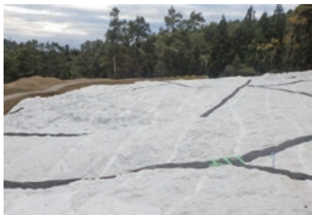
暗渠排水材敷設
