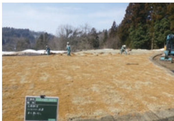
張芝目土敷均し作業
