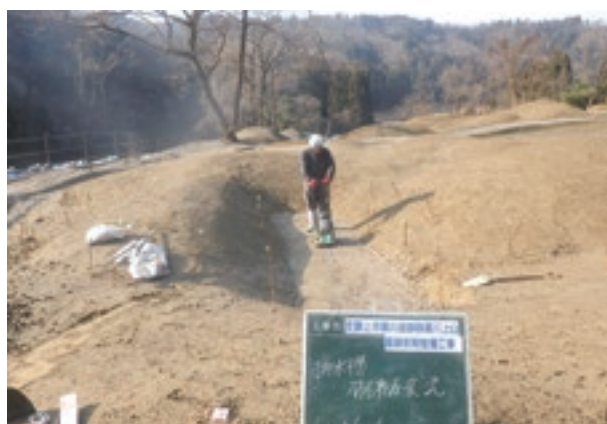
排水層 碎石転圧作業
