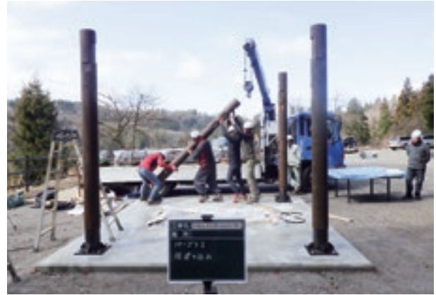
パーゴラ設置作業
