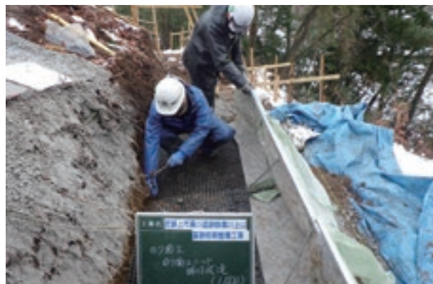
補強土壁工のり面ユニット据付作業
