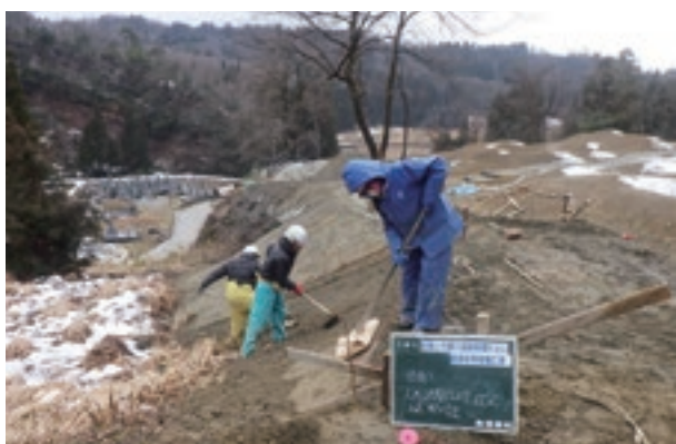
法面整形作業
