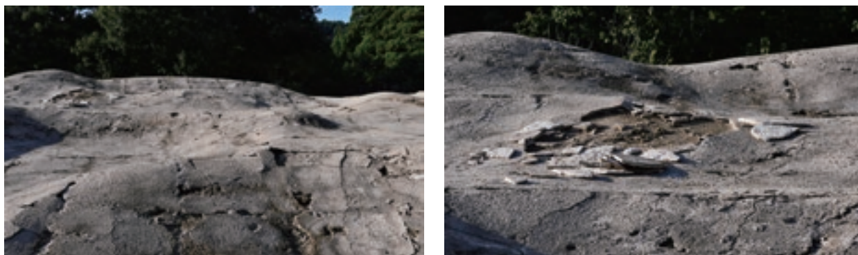
図 6.1.1 遺構亀裂写真
