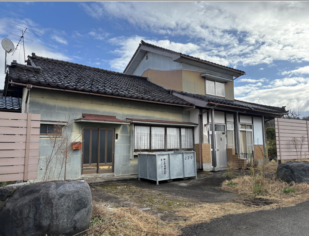
・空き家の外観(南西側)
