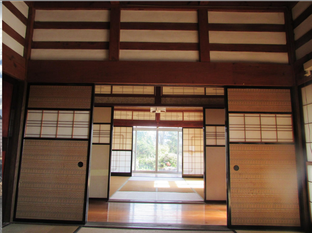
・空き家の内観(1階和室)
