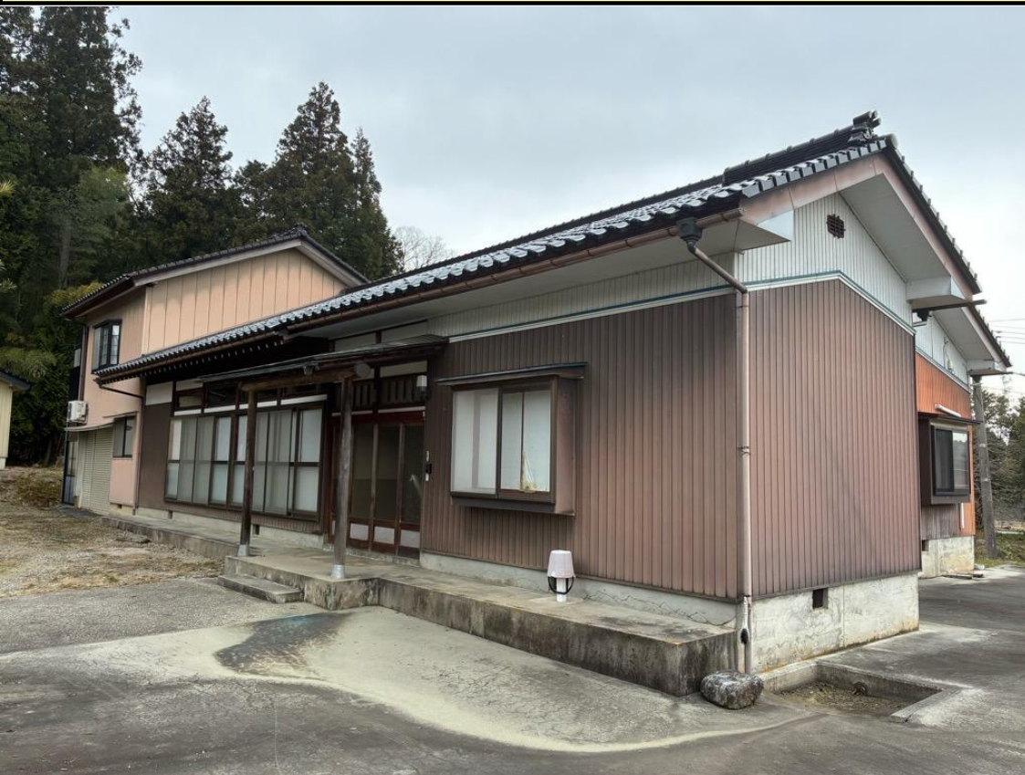
・空き家の外観(南東側)
