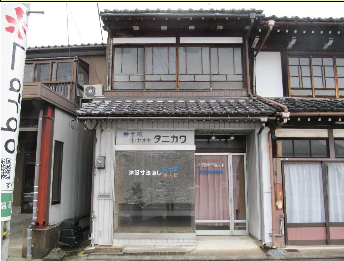
・空き家の外観(東側)
