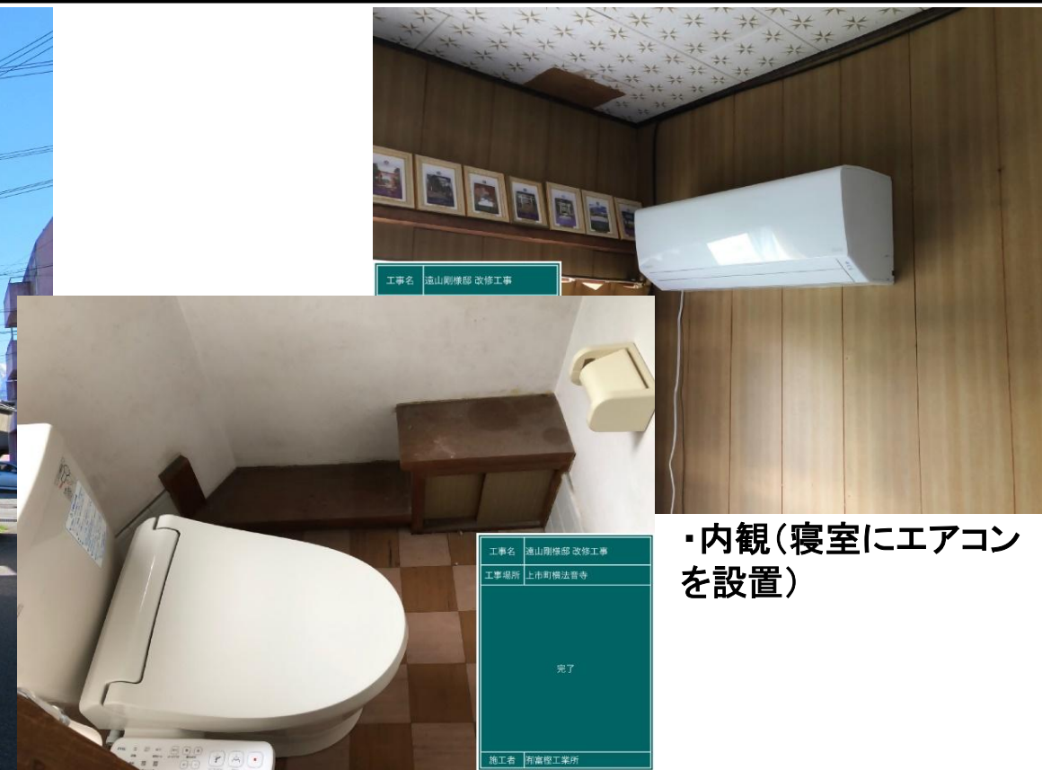
・内観(トイレを水洗化改修)
