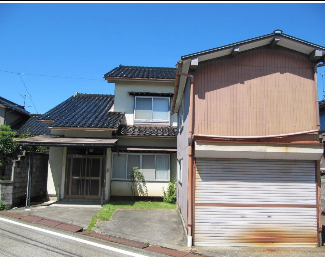
・空き家の外観(南側)
