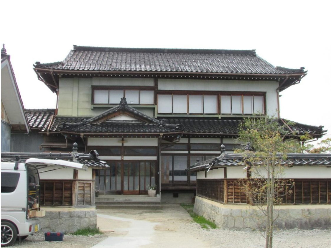
・空き家の外観(東側)
