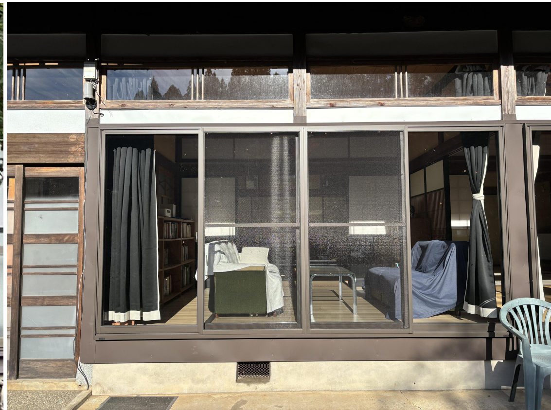
・空き家の外観(外部に面したサッシを断熱窓に改修)
