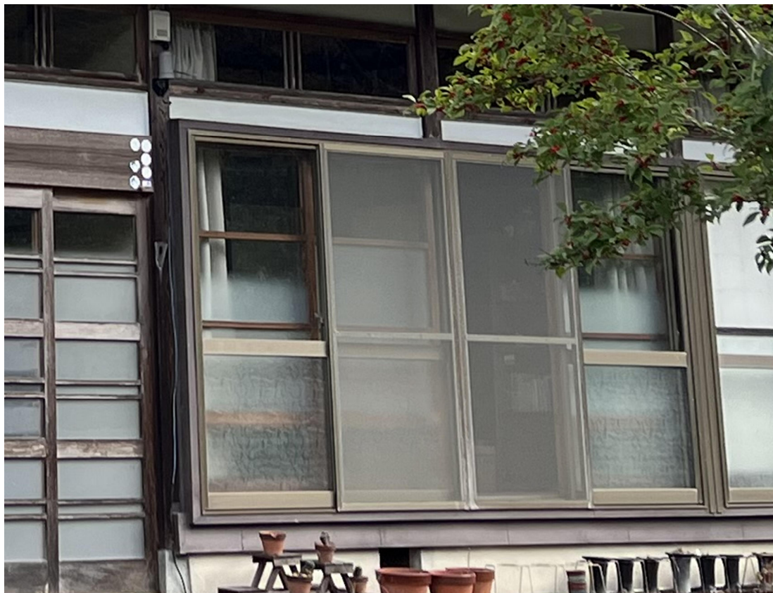
・空き家の外観(南側)
