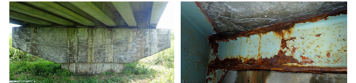
コンクリート橋のひび割れ 鋼材の腐食 (対象橋梁の対策を要する損傷例)
