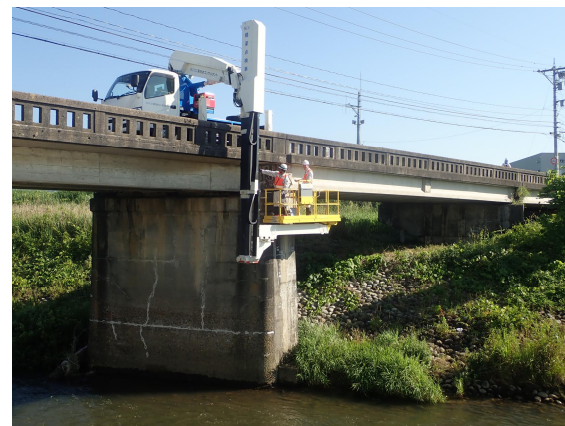
(橋梁側面の点検状況)
