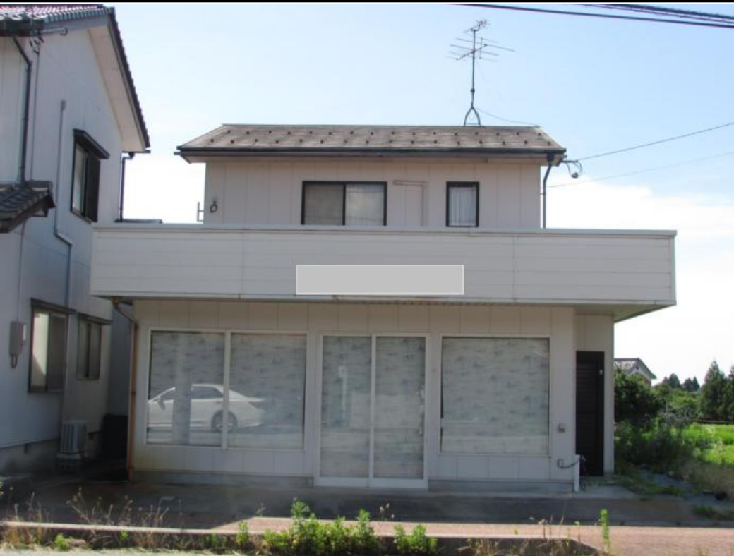
・空き家の外観(東側)
