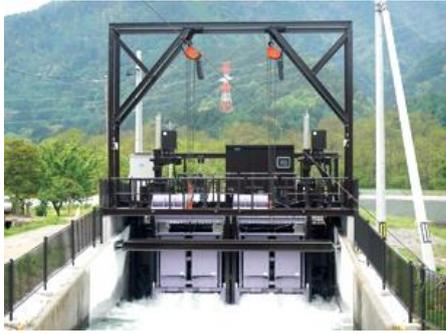
図 5-2-10 低落差型流水式発電設備
