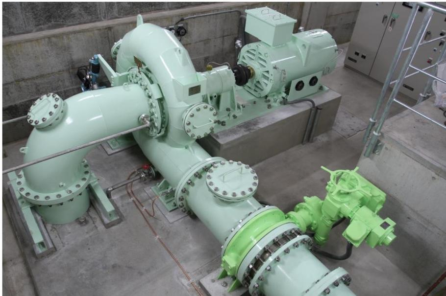
図 5-2-6 199kW の小水力発電導入事例（有田川町営二川小水力発電所:和歌山県）
